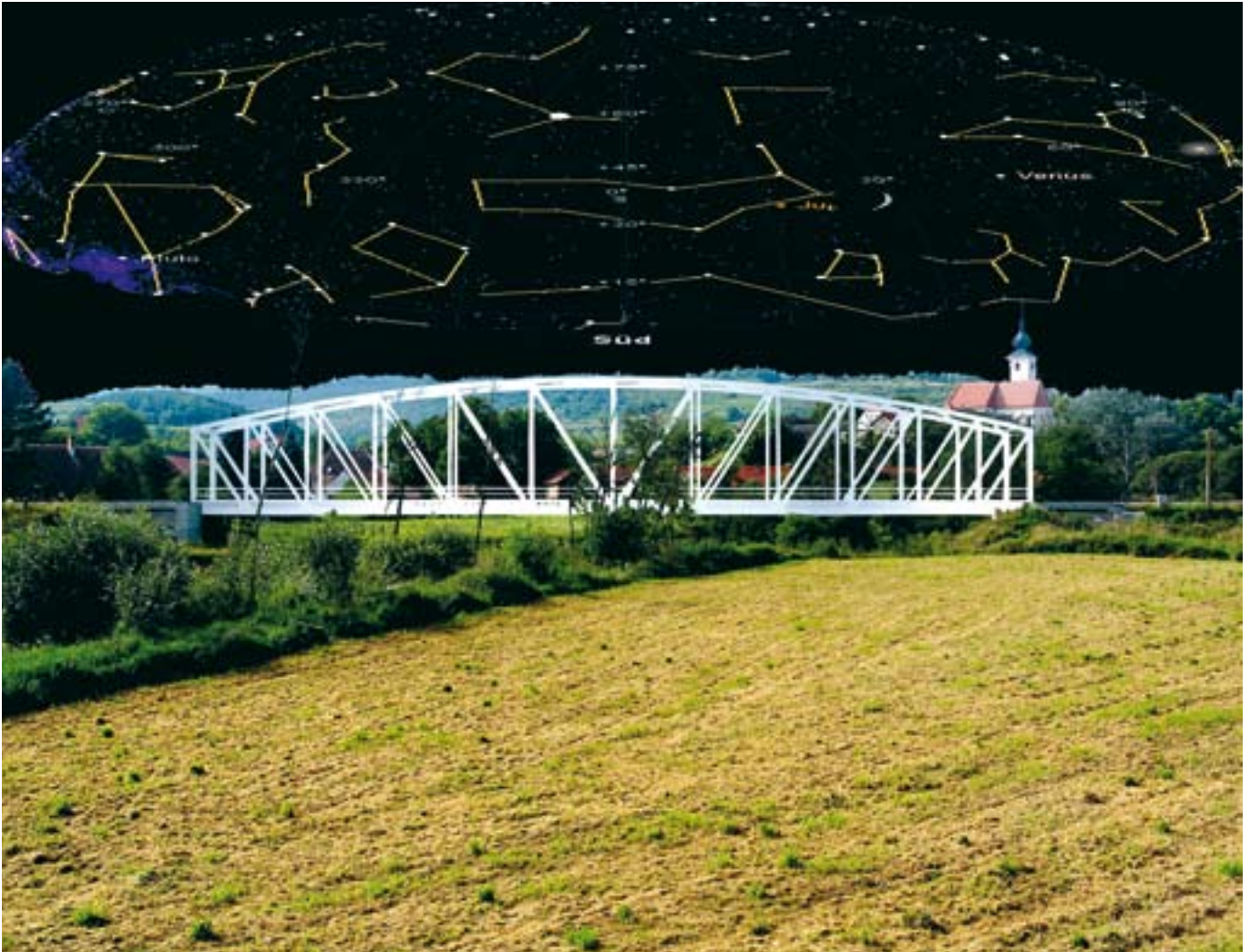
SILBERPFEIL & BOGEN. Kamptal Eisenbahnbrücke. Montage © medienwerkstatt006 / Markus Wintersberger 2005
